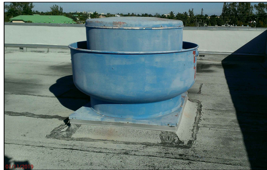
EXISTING ROOF TOP FAN – EXTERIOR
